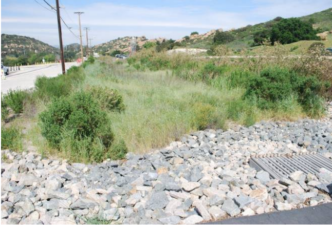
2015: B1436 Detention Bioswales
