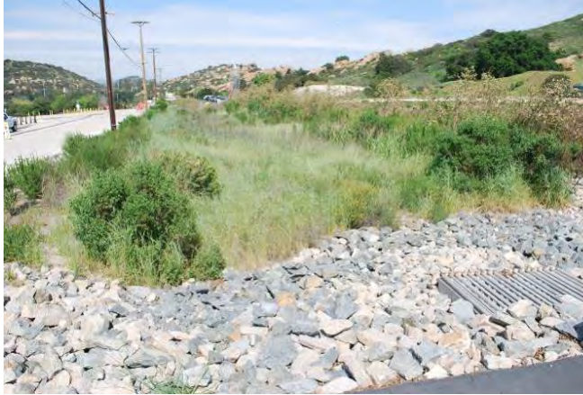
2015: B1436 Detention Bioswales
